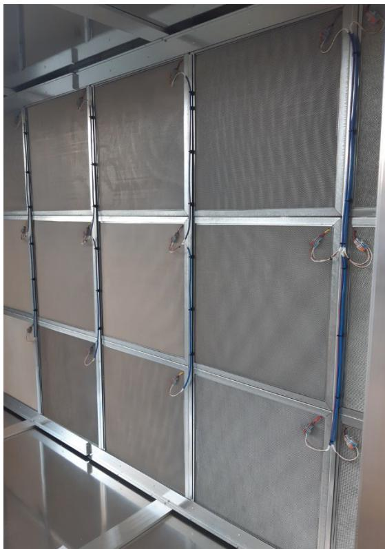
Procéder à la déconnexion électrique des différentes cellules filtrantes
