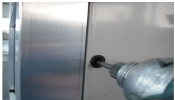
Verrouiller la position du récupérateur au moyen des barres métalliques et de l'utilisation de rivets
