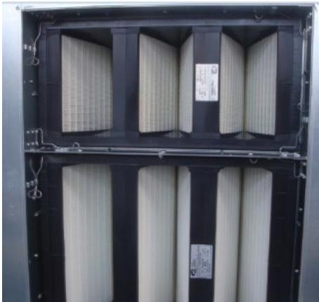
Filtres à manches installés à l'intérieur des contre-châssis
