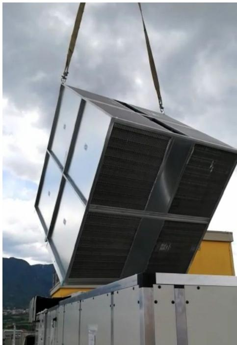
Dans la partie interne du module inférieur les différents panneaux de tôle qui constituent le siège support de la récupération sont déjà préparés et fixés.
