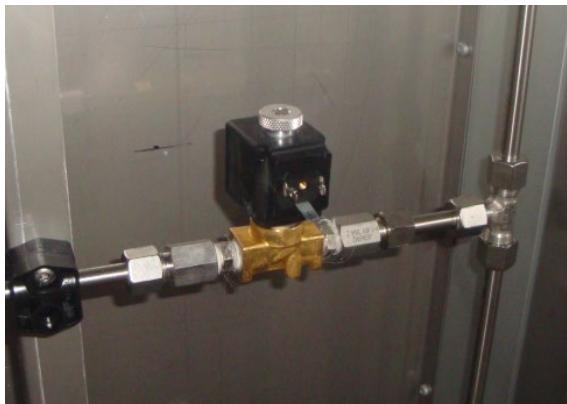
Electrovanne de charge pour systèmes à rampes d'humidification multiples
