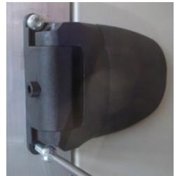
Retirez les entretoises d'angle et ouvrez la porte en vérifiant la bonne position de la charnière. Terminez ensuite la fixation à l'aide des vis autoperceuses.
