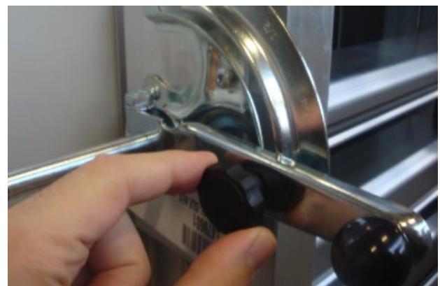
Les volets peuvent être complets avec commande manuelle. Le levier de commande peut être verrouillé en vissant le bouton.
