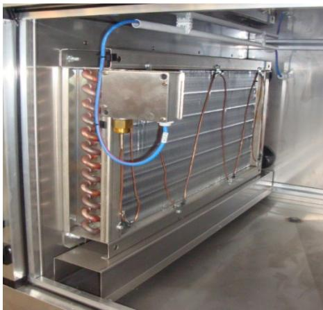
Une sonde de température installée directement sur l'entretoise à travers une bride support peut également être utilisée comme dispositif antigel
