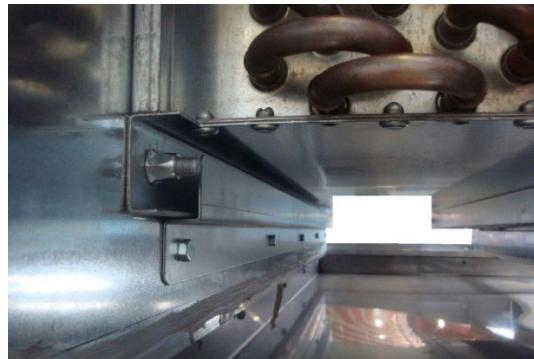
Batterie à détente directe réversible (chaud et froid)
