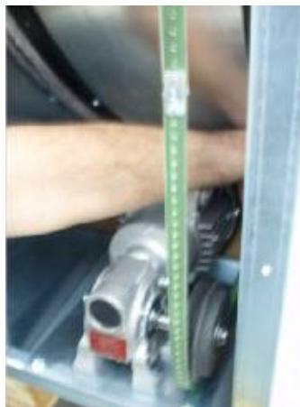
Enfin, vérifiez que la tension de la courroie est correcte avant de démarrer le moteur.
