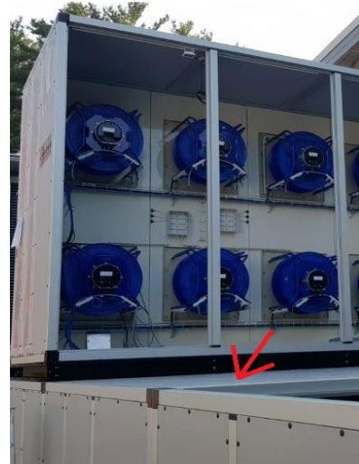
Dans le cas des centrales de traitement d'air avec modules côté à côté, il est nécessaire de siliconer la partie supérieure du toit toujours dans la zone de contact avec l'autre module et le long du profil de jonction.
