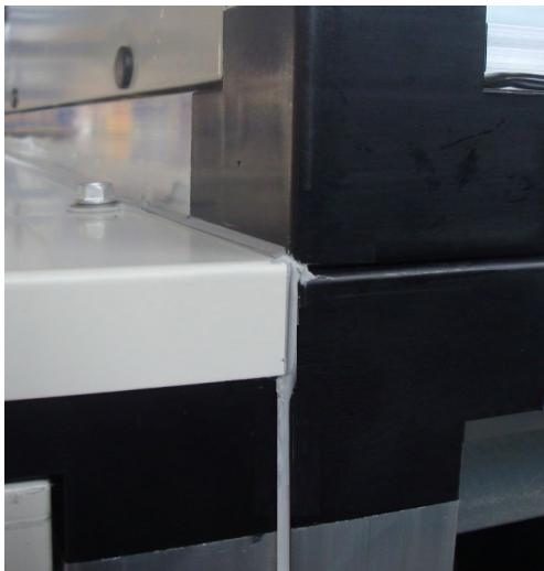
L'étanchéité doit également être réalisée dans toutes les zones de raccordement entre la machine et les canaux d'air et d'admission d'air extérieur correspondants. En présence de volets, du silicone doit être appliqué le long du bord des volets pour éviter une éventuelle infiltration d'eau.
