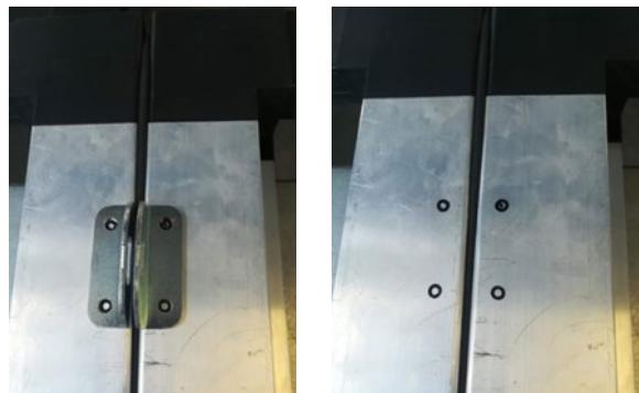
Percer des trous de 9 mm de diamètre
