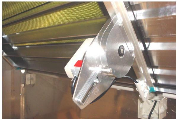
Détail de la plaque support de l'actionneur du registre by-pass d'un récupérateur de flux transversal
