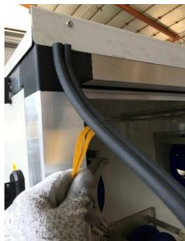
Étalez progressivement le joint sur le profil qui l'accompagne et serrez-le doucement le long de celui-ci. À la fin du profil, coupez le joint résultant. Cette procédure doit être répétée de la même manière, pour toutes les pièces qui entrent en contact entre les différents modules, afin d'avoir un parfait étanchéité à l'air.
