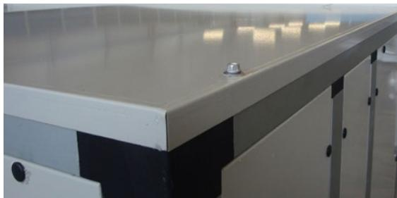
Entre la feuille et le panneau, un joint est placé dans la zone centrale pour créer une pente pour le drainage de l'eau.
