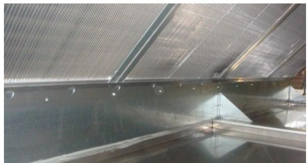
Du côté de l'entrée d'air extérieur sont logés des filtres généralement plats qui sont nécessaires pour protéger le récupérateur.
