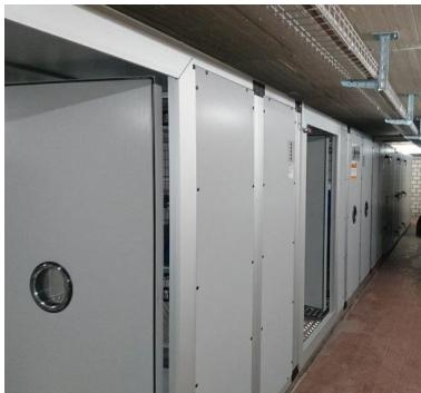
Un positionnement correct de l'unité nécessite un positionnement sur une plate-forme ou une base appropriée constituée de poutres. Cependant, il peut arriver que le béton ou les poutres de support présentent une rugosité ou des irrégularités importantes: dans ce cas, l'installateur se chargera de caler la base des profilés avec des tôles de fer ou autre afin de niveler la base de l'unité.
