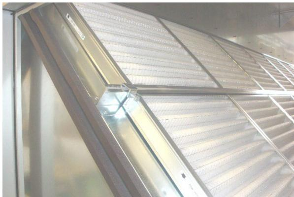
Ces récupérateurs sont constitués de plaques d'accouplement qui laissent alternativement passer l'air expulsé et l'air extérieur. La distance entre les plaques est l'un des facteurs qui détermine l'efficacité de l'échangeur. Souvent, la distance entre les plaques est obtenue au moyen de reliefs qui améliorent l'échange thermique.
