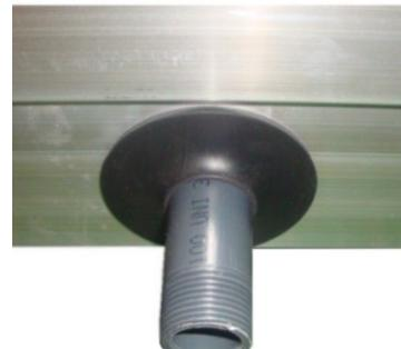
Détail de la vidange externe du réservoir avec connexion filetée
