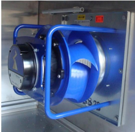
Si le côté aspiration est accessible, un filet de sécurité est installé en standard pour éviter tout contact avec la roue elle-même.
