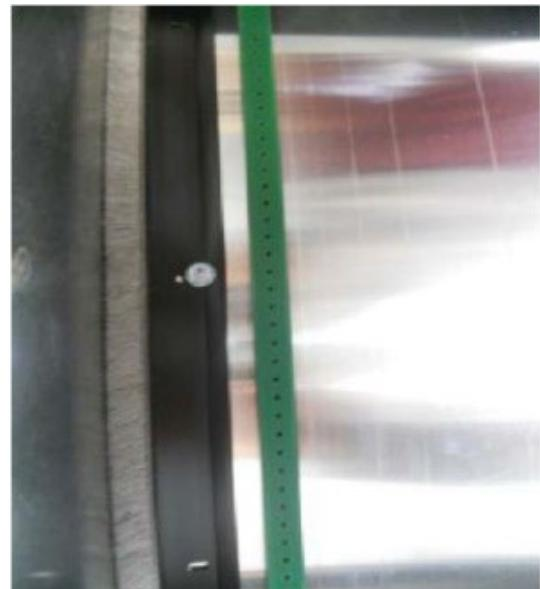
Pour remplacer les balais, desserrez les vis de fixation sur le joint et sur le rotor. Retirez les brosses de l'échangeur rotatif puis remplacez-les par les mêmes brosses de rechange, en prenant soin de les positionner correctement. Serrez les vis et vérifiez le bon fonctionnement de la roue.
