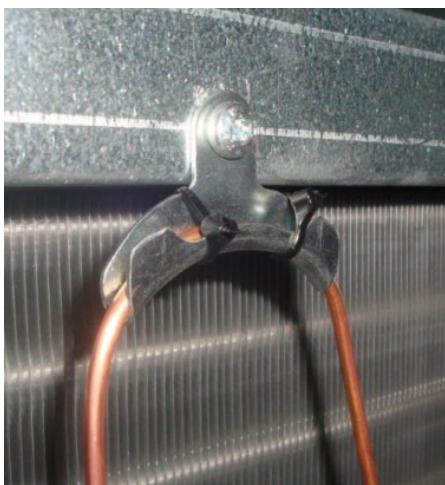
Dans le cas de plusieurs batteries en série, une entretoise est créée à l'intérieur de laquelle le thermostat antigel peut être installé sur un guide coulissant.
