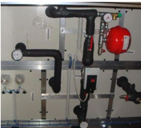
Exemple de raccordement hydraulique pour batteries jumelées
