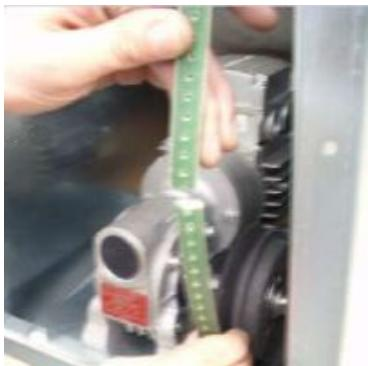
Remplacement de la courroie dans les récupérations rotatives
