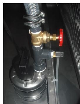
Pour les systèmes d'humidification adiabatique avec recirculation de l'eau, la pompe est équipée d'un robinet de vidange indiqué par un cercle rouge pour effectuer la purge. Une purge continue d'une
