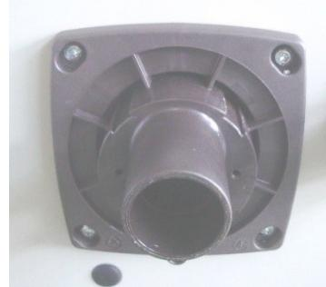
Fixation de la baguette d'humidification à la vapeur
