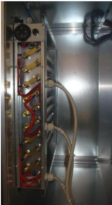
Détail de la connexion du radiateur électrique. Exécution spéciale avec connexions latérales plutôt que frontales
